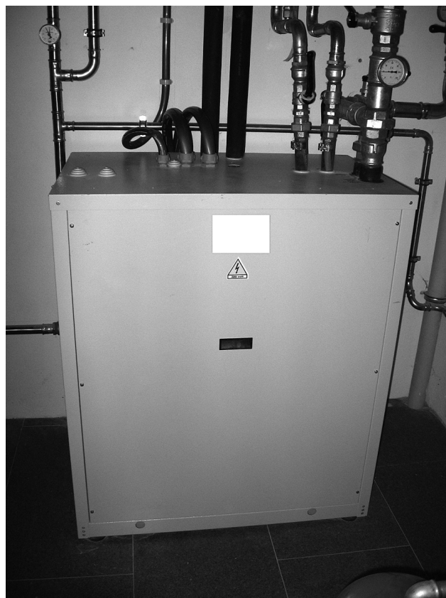
Fig. 6.10 – Pompa di calore installata su un impianto di riscaldamento di un'abitazione (foto L. Micheletti).
